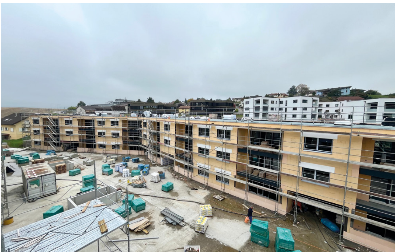
Le lotissement de La Poya à Farvagny, un chantier d'envergure avec l'utilisation du swissporTERA White.
